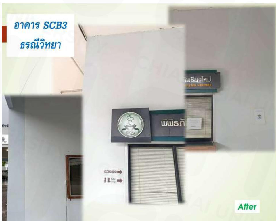
งานซ่อมแซมอาคารที่ได้รับผลกระทบจากเหตุการณ์แผ่นดินไหวเมื่อวันที่ 28 มีนาคม 2568
