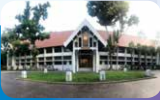
อาคารฝั่งทางเข้าหลัก
