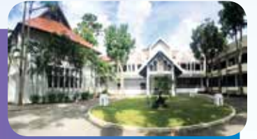
อาคารฝั่งทางเข้ารอง
